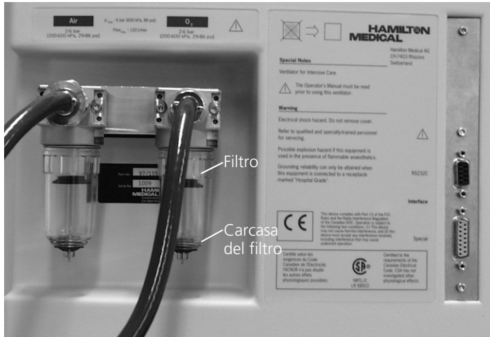
Figura 10-2. Sustitución de un filtro de suministro de gas
