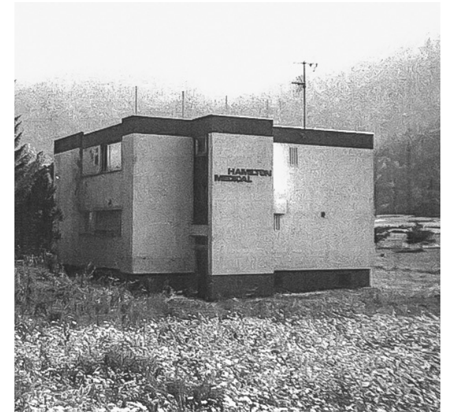
Erstes Gebäude der Hamilton Medical AG in der Schweiz
